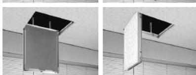
開閉方向を変更する場合は、外枠にビス止めしている「上り止め」の位置を変えて下さい。
