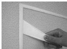
①樹脂製のヘラ等壁の仕上げを傷付け難いものを枠の内側に差込みます。
