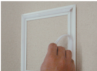
① 軟質のキャップを4辺全て取り外します。角の部分から外すと外し易いです。
