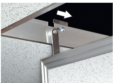
外枠のストッパーをずらして内枠のアームごと取り外して下さい。
