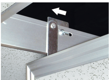
内枠のアームを外枠の切り欠き部に合せて、外枠のストッパーを所定の位置に戻し、取り付けして下さい。
