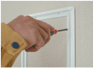
② 取付けビスをドライバー等で全て取り外します。
