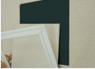
③ 点検口枠と内ふたボードを取り外します。
