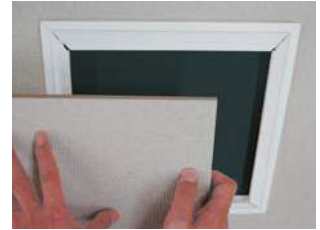
④点検口枠を4辺とも開いたら内ぶたボードを手でしっかり押さえ取り外して下さい。 ※ボードが落下する恐れがありますので十分注意して下さい。
