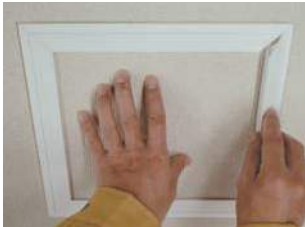
①点検後は内ぶたボードを点検口枠に正確にセットし、パチッと音がするまで確実に閉めて下さい。
