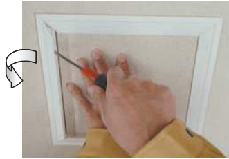
②「マイナスドライバー」を枠の外側に向けて、押しながら下に向けて「枠の1辺」が開きます。
