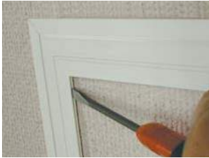
①「マイナスドライバー」を枠の内側の溝に差し込みます。 ※仕上げ材をキズつけないように注意して下さい。
