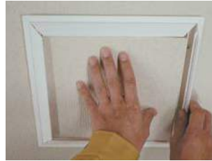
③内ぶたボードを手でしっかりと押さえながら枠の全て(4辺)を開きます。(1辺を開くと残りの3辺は開き易くなります) ※内ぶたボードをしっかり手で押さえないと落下する恐れがありますのでくれぐれも注意して下さい。
